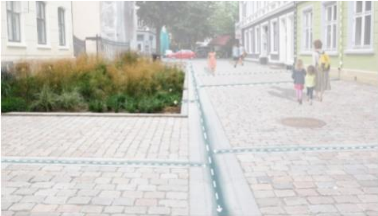
Utsnitt av bygata hvor det er bygget renner i granitt som fører overvann fra gateplanet. Kilde: Asplan Viak
