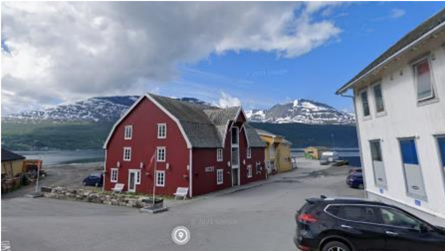
Strandveien nord/ bygget til Sør-Troms museum. Kilde: Google maps
